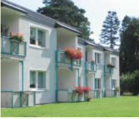
Die zweigeschossigen Häuser im Marienburger Weg sind von weiten Grünflächen umrahmt.
