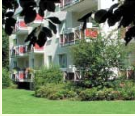
Prägnante Balkons zwischen altem Baumbestand in der Gottlieb-Daimler-Straße.
