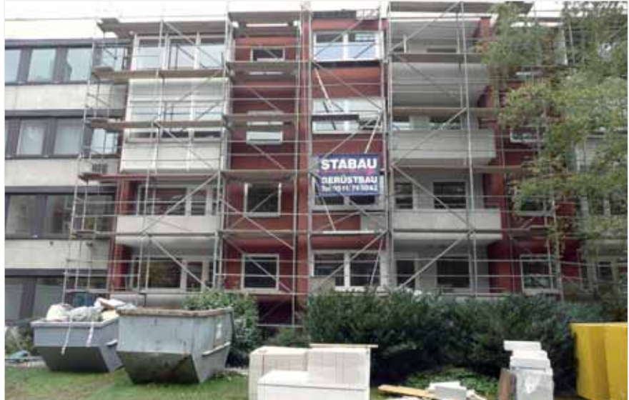
Platz an der frischen Luft: Die Balkons werden wieder geöffnet, neue Fenster eingesetzt.
