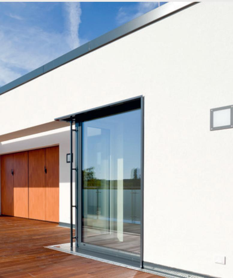
Das IBA-Objekt in Hamburg-Wilhelmsburg: attraktive Fassadenfertigteile aus Sichtbeton statt des gängigen Wärmedämmverbundsystems
