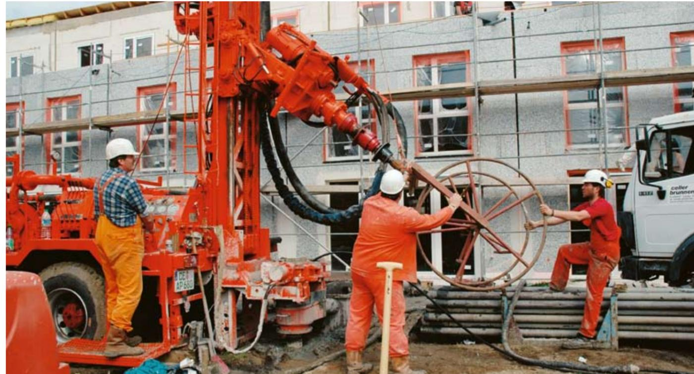
Baubeginn für sieben komfortable Reihenhäuser mit Geothermieanlage: Fünf Tiefbohrungen sind zur Gewinnung der Erdwärme notwendig, um die sieben Reihenhäuser mit der kostenlosen Energie aus der Tiefe zu versorgen. Herzstück der Anlage ist eine innovative Heizzentrale mit einer Gas-Absorptions-Wärmepumpe. Die Wohnfläche eines Mittelhauses beträgt ca. 129 m<sup>2</sup> und die eines Endhauses ca. 135 m<sup>2</sup>.
