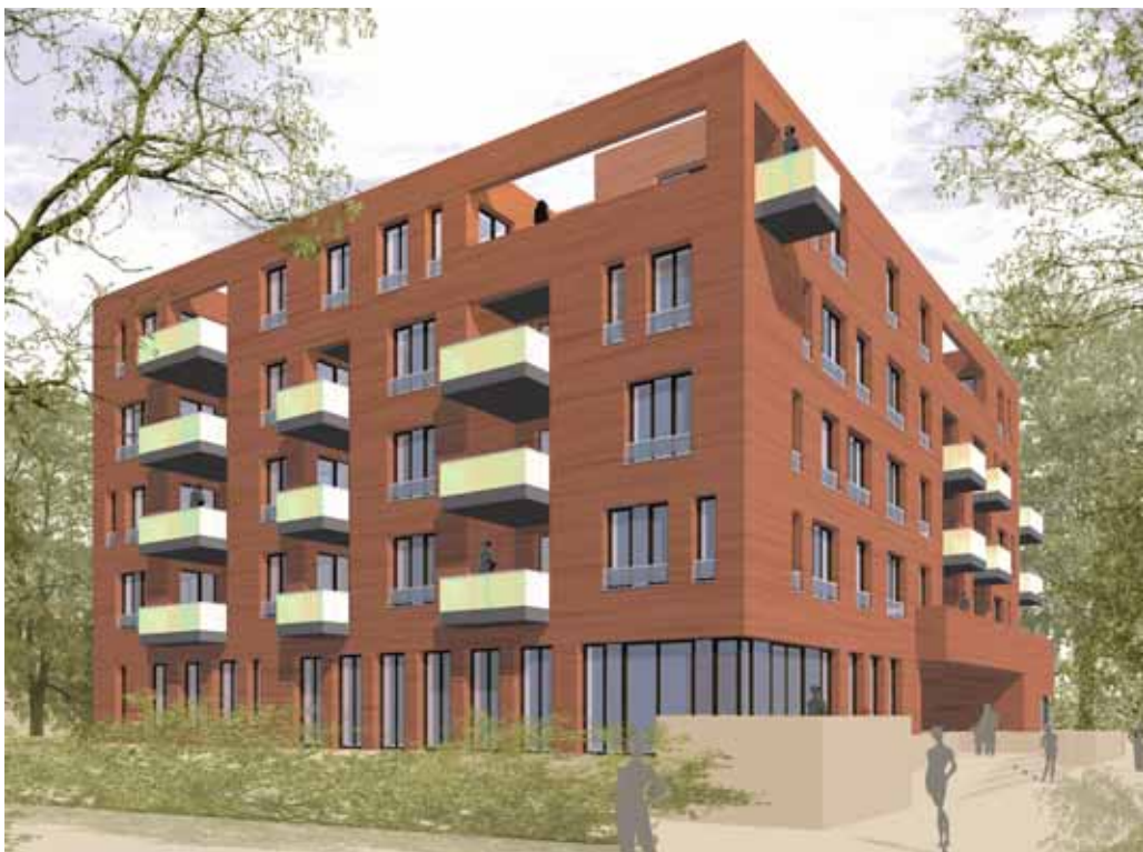
Markante Fassaden mit hellen Balkons geben Langenhagens Zentrum ein neues Gesicht.
