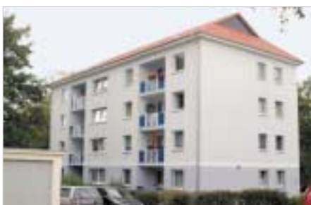
Neuer Dachaufbau und schöne Loggien in der Wilhelm-Busch-Straße.
